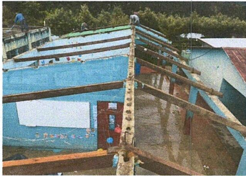
FOTO 4. SUSTITUCIÓN DE TECHO DE LAMINA, MODULO 2
