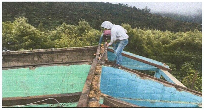
FOTO 2. SUSTITUCIÓN DE ESTRUCTURA DE SOPORTE DE MADERA
